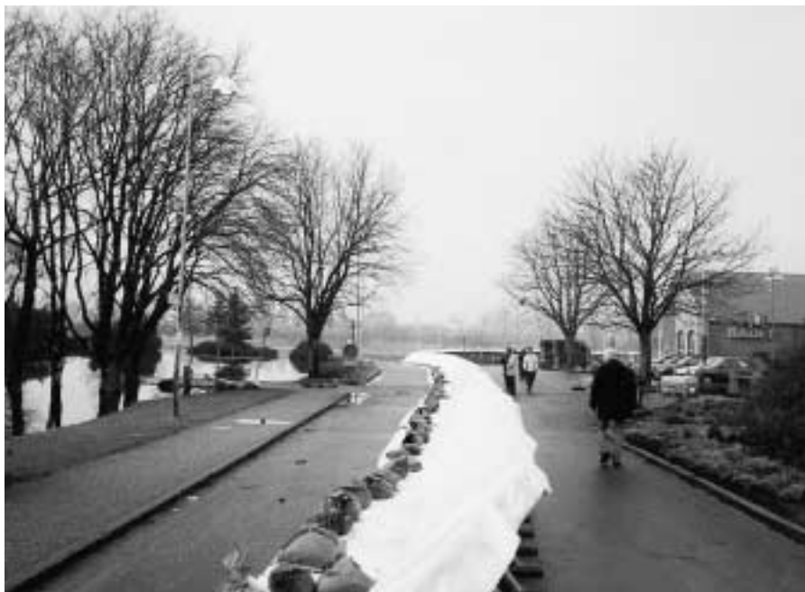
Beredskap inför fortsatt översvämning genom monterbar vall bestående av plåtställning och tjock plast som hålls fast nere mot marken genom sandsäckar. (Foto författaren)
